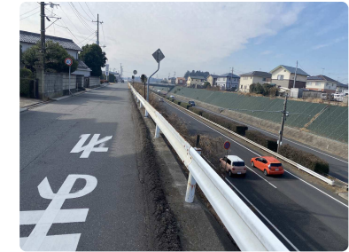
幹線道路を下に見て歩いたり
