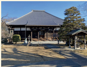
再建された坂東報恩寺(下総)
